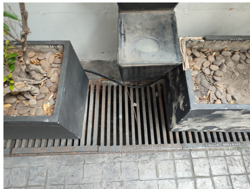
3-26 รางระบายน้ำด้านหน้าโครงการ ไม่มีเศษขยะอุดตันที่ระบายน้ำ
