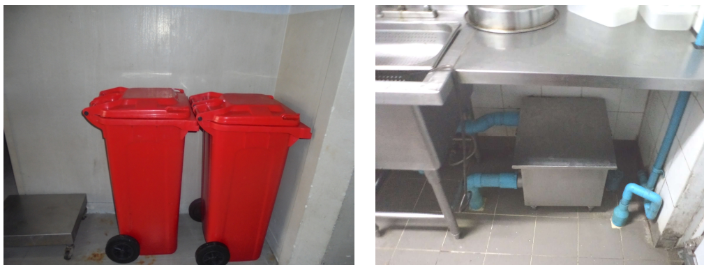
3-7 ถังขยะติดเชื้อและถังดักไขมันบริเวณห้องครัว
