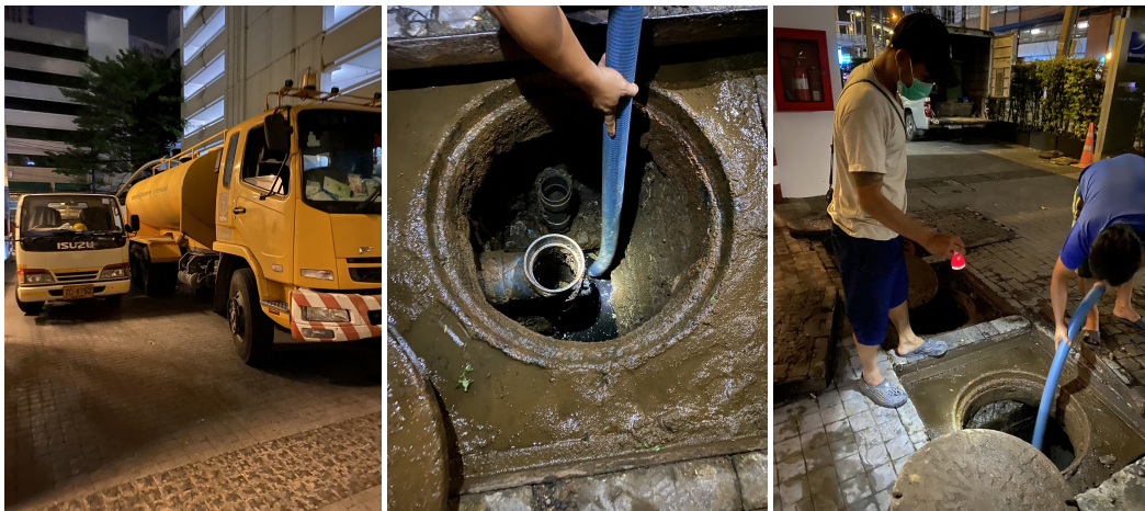
ภาพที่ 3-30 ดูดตะกอนที่บ่อเกรอะ
