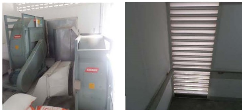
3-11 ระบบระบายอากาศด้วยวิธีธรรมชาติและพัดลม อัดอากาศ
